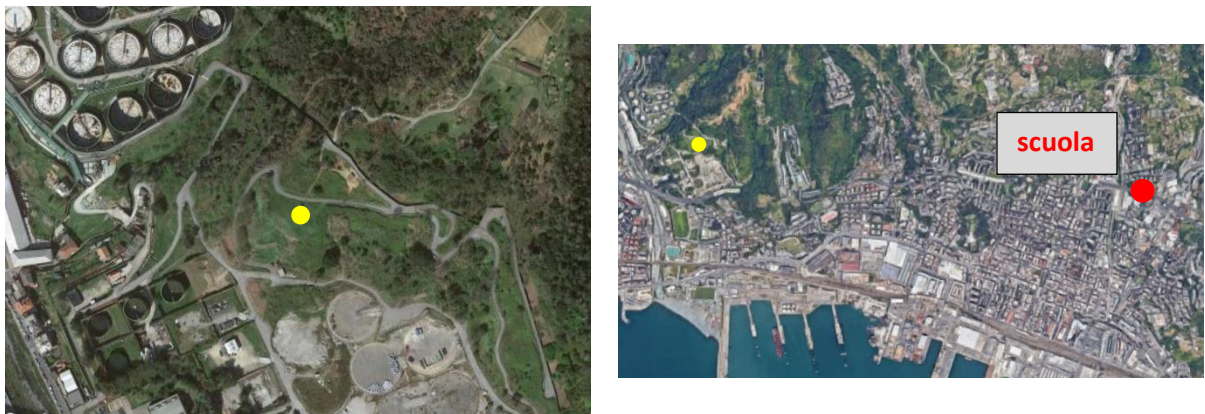
Figura 3.1 – Posizionamento della centralina meteo climatica rispetto all'edificio oggetto di DE
