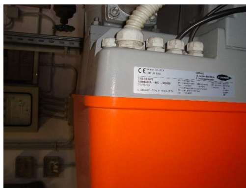
Figura 4.12 - Particolare targhetta bruciatore
