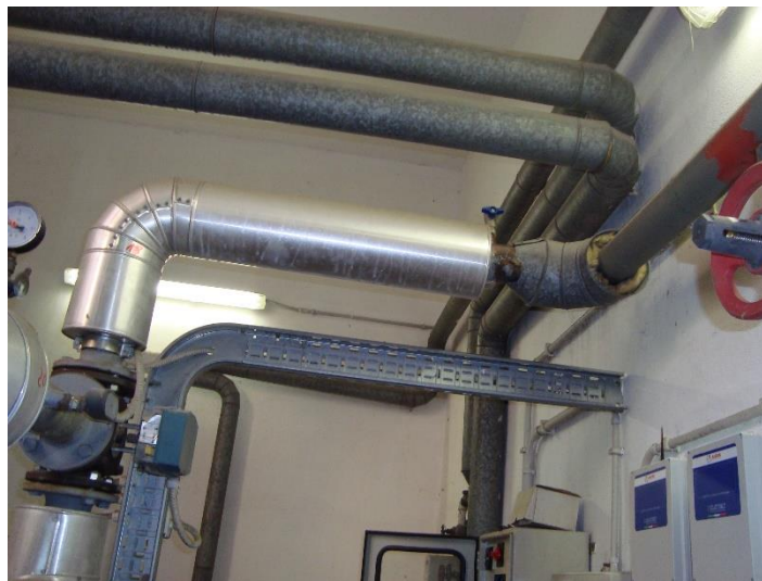
Figura 4.8 – Particolare valvola a tre vie
