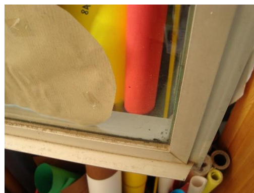
Figura 8.1 – Particolare dei serramenti esistenti
